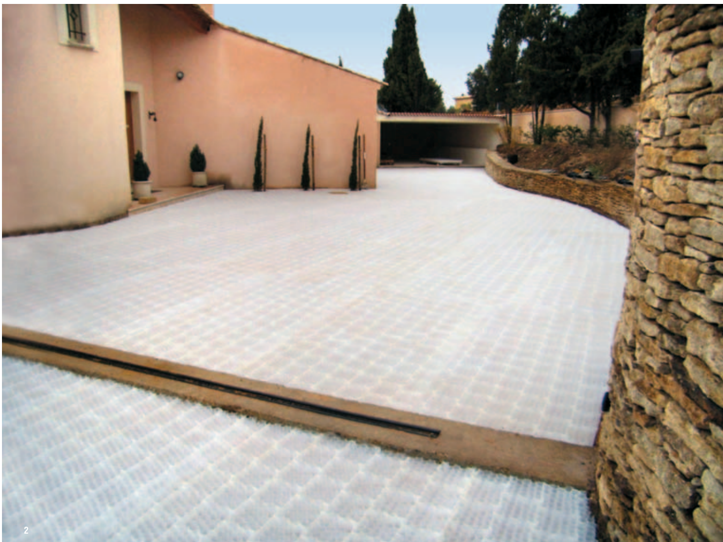
1. Preparazione del fondo. 2. Posizionamento dei pannelli GravelFix . 3. Prodotto applicato con GravelFix .
